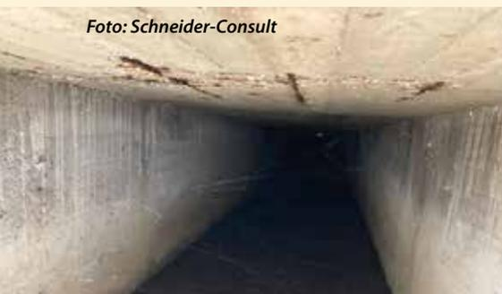
So schaut's aus unter der Altabach-Abdeckung. Das durch die Decke durchgesickerte Wasser hat die Stahlbewehrung in dieser stark in Mitleidenschaft gezogen.
